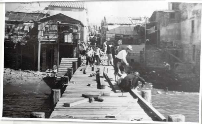
風災後重修木橋
