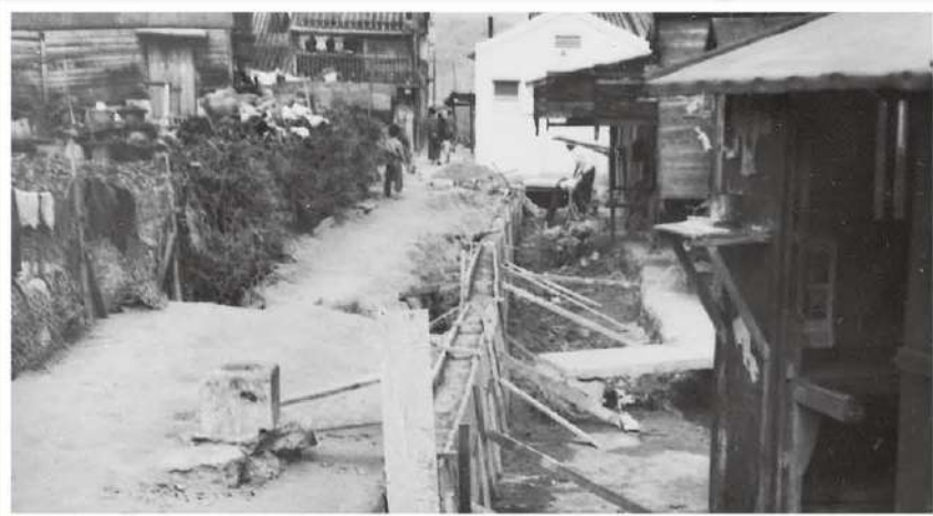
修建中興後街大水渠
